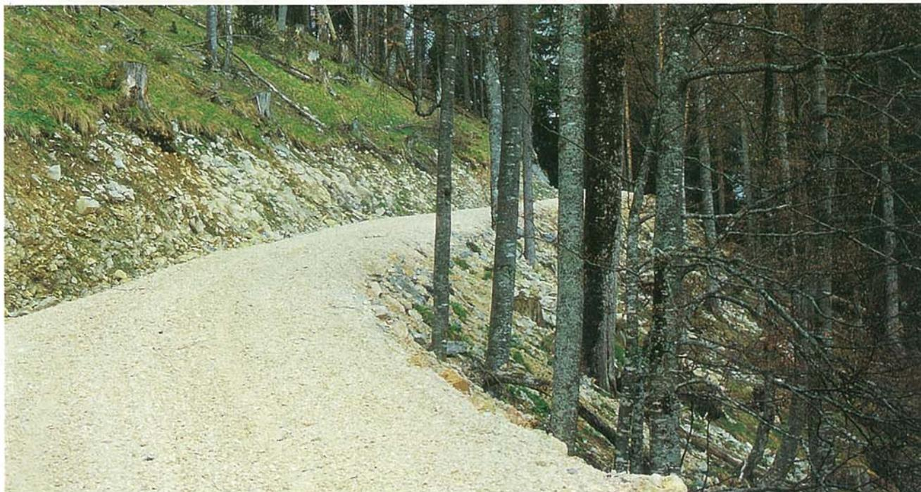
Beispiel einer schonend angelegten Forststraße während der abschließenden Bauphase bei Hallstatt. Aufgrund der Zusammenarbeit zwischen Forst und Naturschutz konnte eine dem Gelände angepasste Trassenführung gefunden werden.
